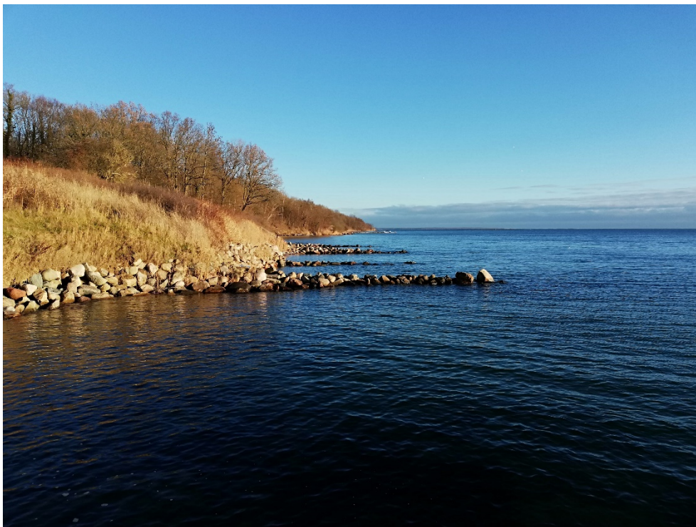
Figur 5. Kyststrækningen mod nord er beskyttet med hård kystsikring. Der blev udlagt nye sten omkring 2015. Erosionen er her betydelig mindre.
