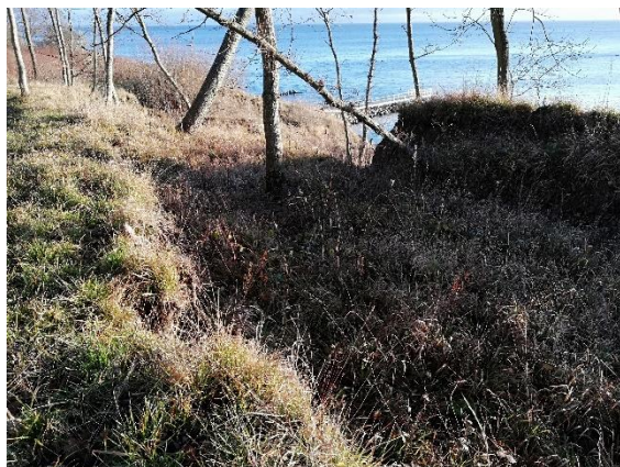
Foto 4. Lerskrænt er skredet ca. to m ned. (2020).
